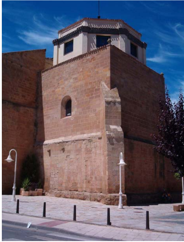
Exterior de Capilla Mayor y cruceiro
