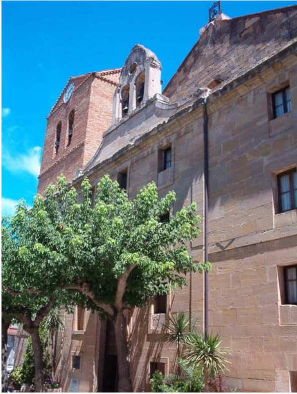
Vista de la fachada
